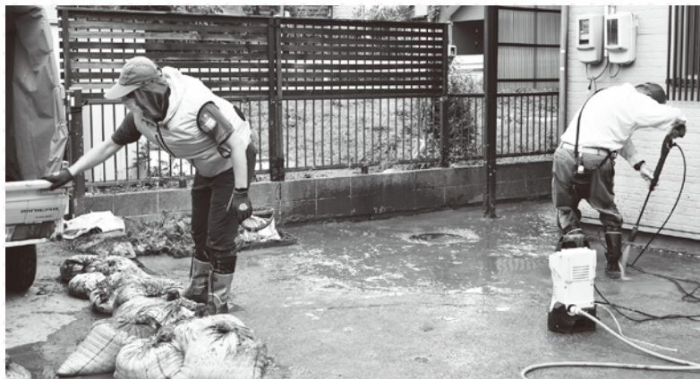
泥出しや土砂の除去、家具の運搬などを行いました
